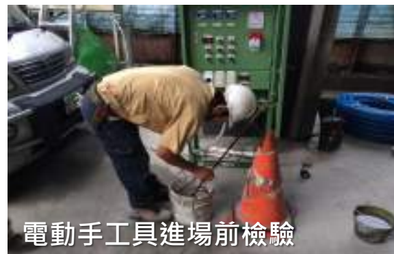
用電裝置進場需經漏電測試
