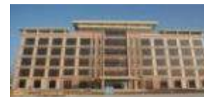
窗型BIPV發電系統
