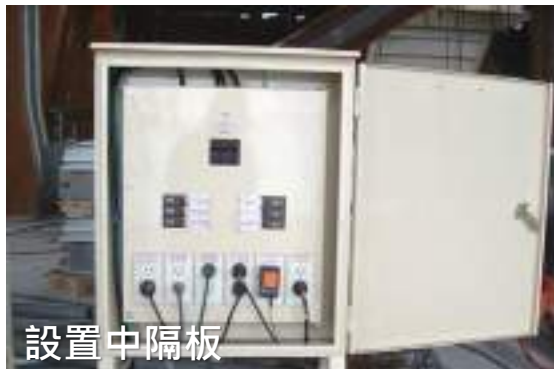
設置漏電斷路器
